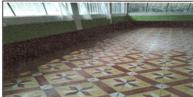
Foto 4: Área general del establecimiento, Sustrucción de piso de granito por (cerámico)
