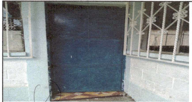
Foto 2: Área de aula 1 y 2: Sustrucción de chapa, mantenimiento a estructura sujeciones y aplicación de pintura
