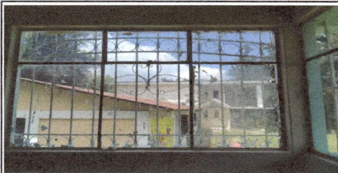
Foto 3: Área general del establecimiento: Sustrucción de metal de ventana (por pvc)
