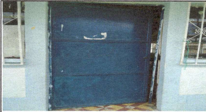
Foto 1: Área de dirección: Sustrucción de chapa, mantenimiento a estructura sujeciones y aplicación de pintura
